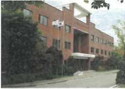
본관동 - 강의실, 캐드실, 컴퓨터실, 사무실, 회의실 등
