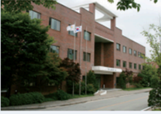
본관동 - 강의실, 캐드실, 컴퓨터실, 사무실, 회의실 등
